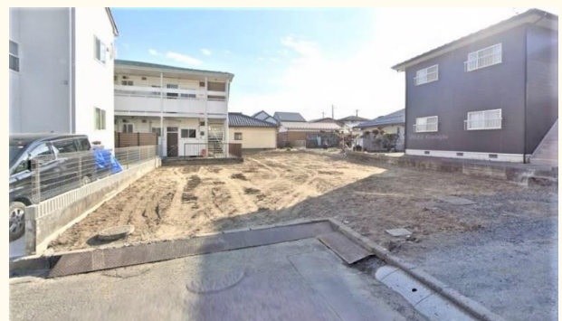
解体後の土地
